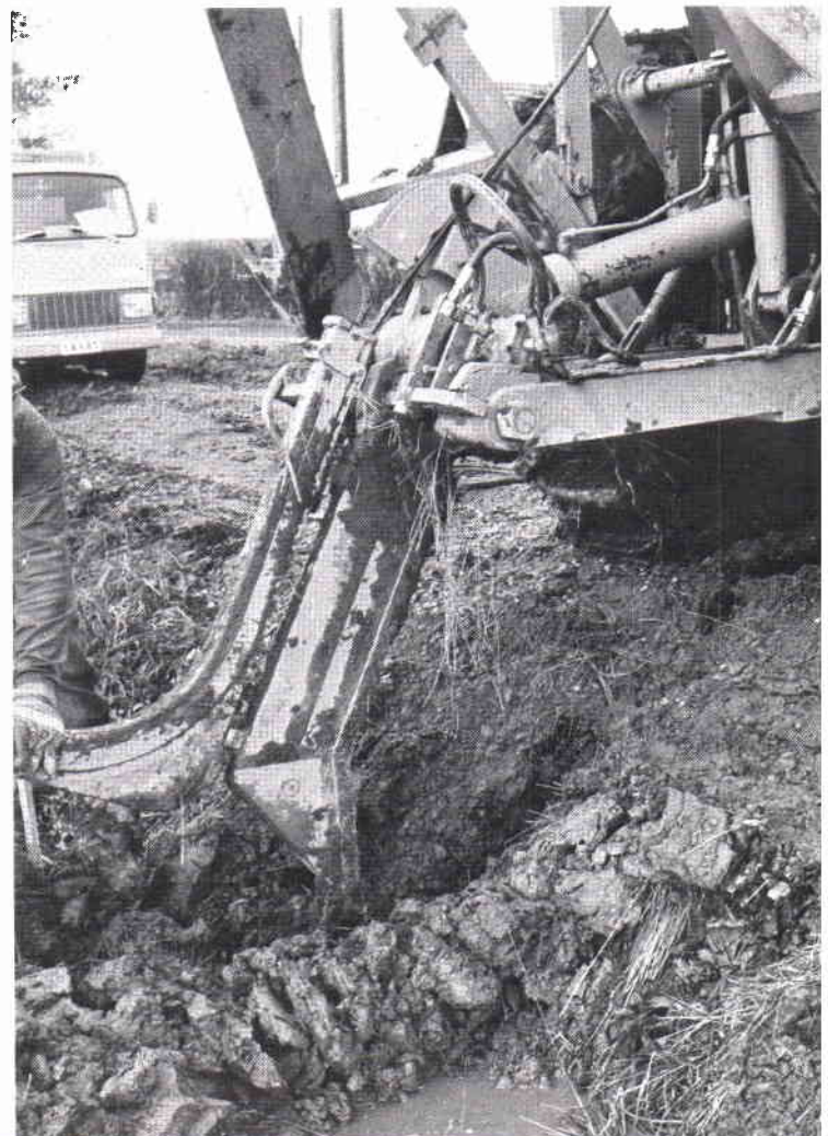
Televerkets kabelplog lägger kabel genom vägbank.
